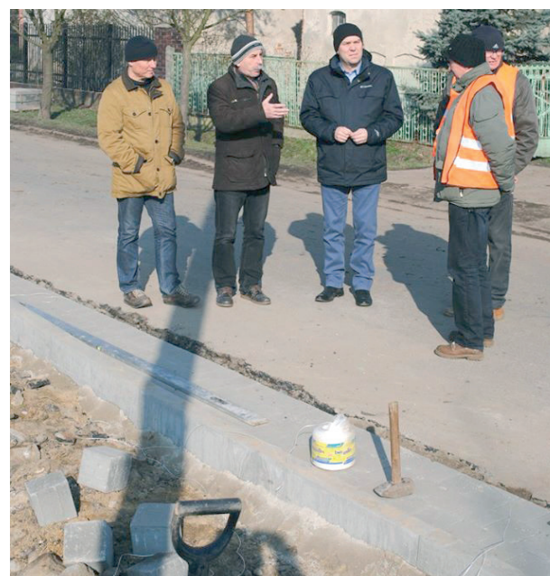
Burmistrz Poprawa z pracownikami Urzędu nadzoruje prace
