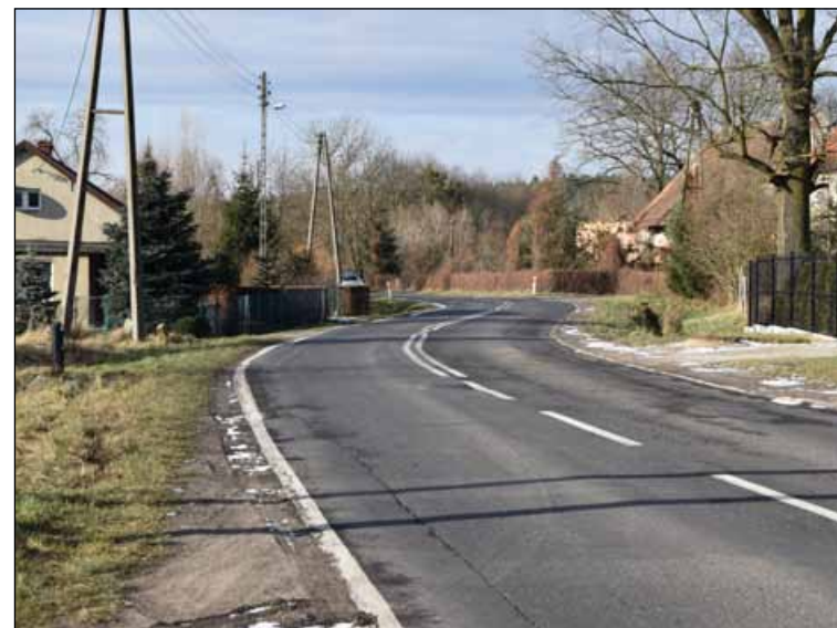
Przy drodze w Rościszawicach powstanie ciąg pieszy.
