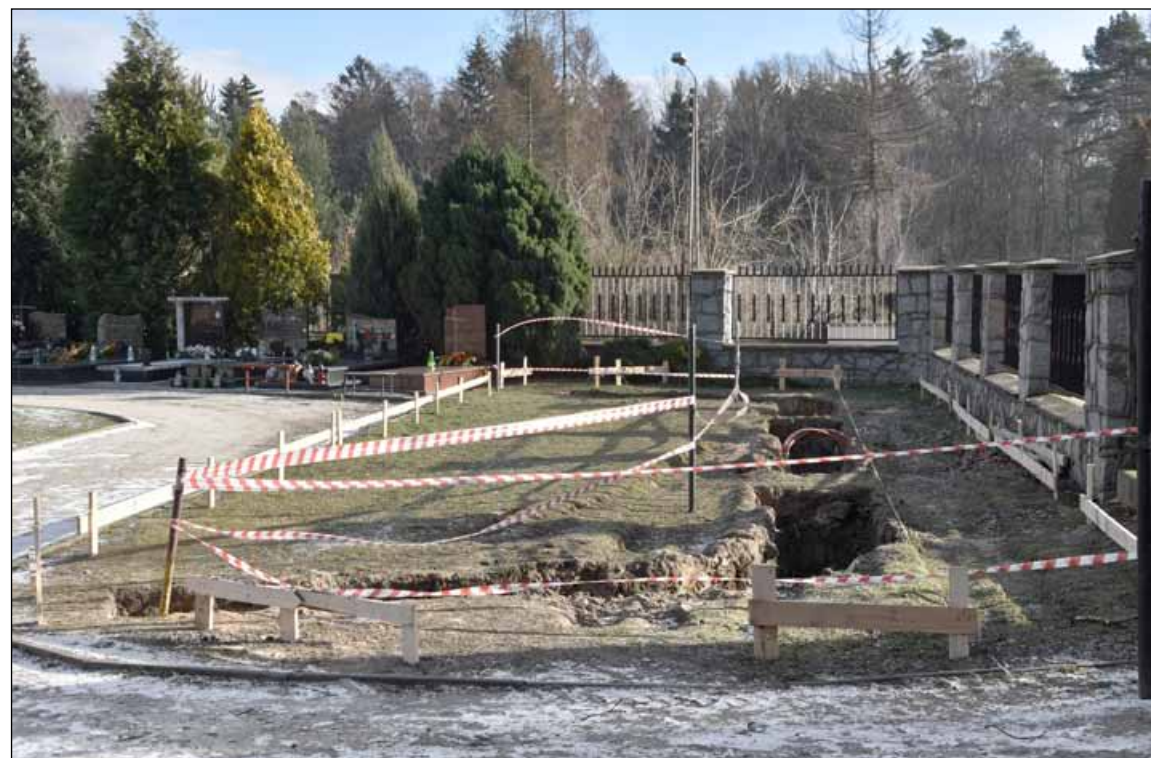
Rozpoczęto prace przy budowie kolumbarium na cmentarzu.
